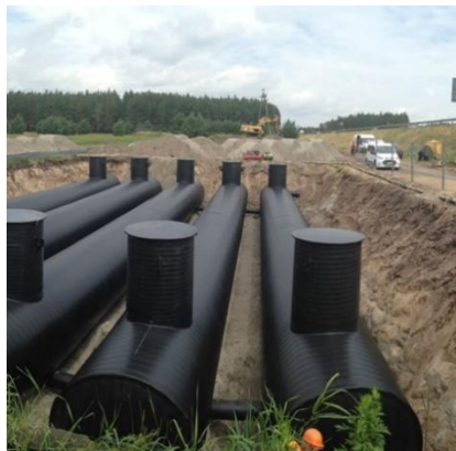
Ryc. 11 Zbiorniki podziemne, źródła (od lewej): https://www.uponor.pl ; https://ecol-unicon.com/produkty/produkty-deszczowe/zbiorniki-retencyjne-hydrozone/
